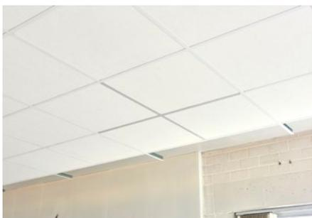
En estas fotos, se instaló un techo con el modelo de perfilería Chicago Metallic Matt White 11, salvo en la parte en forma de cruz, que se realizó con una perfilería estándar para facilitar la comparación.
